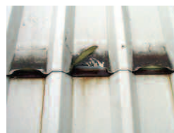
Narvlæderpræget alternativ på traditionel varmgalvaniseret underlag efter 7 år.
