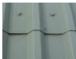
Colorcoat HPS200 Ultra® med Galvalloy™ tag efter 7 år.
