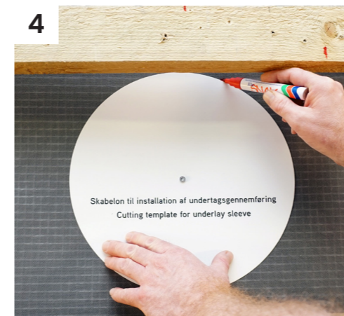
4 Afmærk rundt om skabelonen for udskæring af hul.
